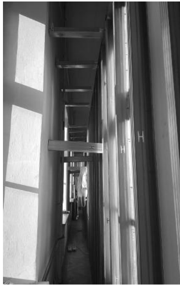
Fot. 3. Konstrukcja wewnętrznych ścian wystaw. Widok od zaplecza, Muzeum Archeologiczne i Etnograficzne w Łodzi
