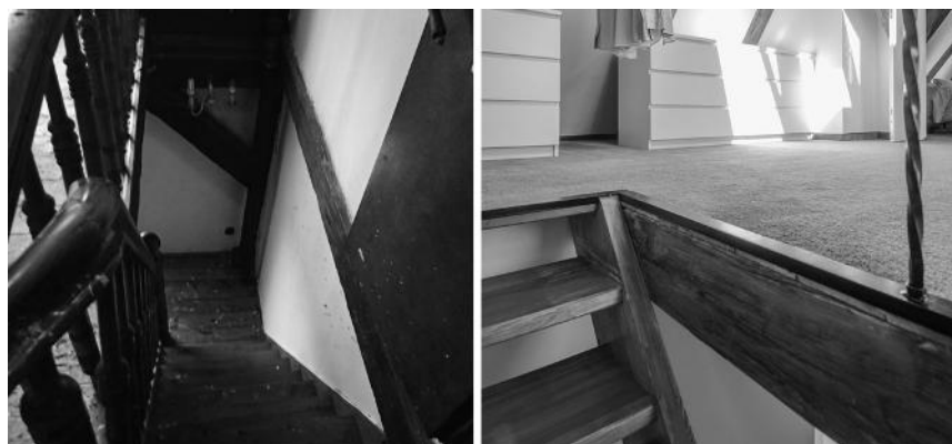
Il. 6. Schody. Widok przed i po
